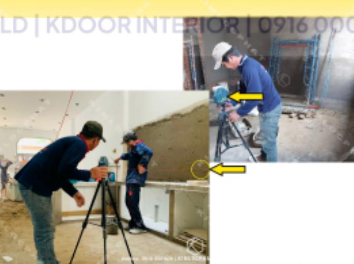
Máy cân mực laze sử dụng loại máy BOSCH, hạn chế dùng các loại máy xuất xứ không nhãn hiệu và đặc biệt không sử dụng ống nước cân mực thủ công theo các đội thi công truyền thống
